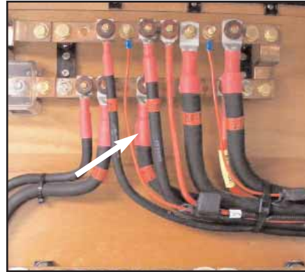
FUSIBILE DEL SISTEMA IDRAULICO (PASSERELLA)
