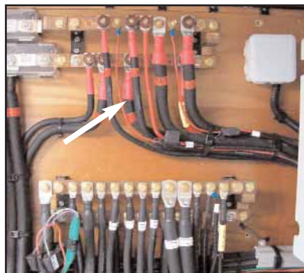
FUSIBLE DEL SISTEMA (PESCANTES)
