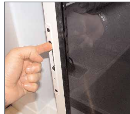
BLOCAGE DE BAIE COULISSANTE
